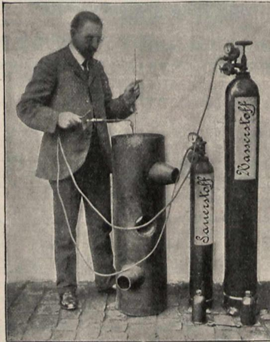
Der vollständige Schweissapparat in Betrieb.
