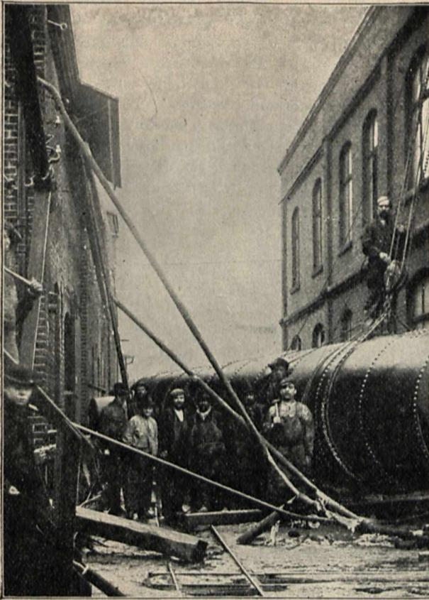
Abb. 44. Mit Thermit geschweisste Rohrleitungen, welche durch einen niederstürzenden Cornwallkessel arg beansprucht wurden, halten ihre Functionen ungestört aufrecht.
