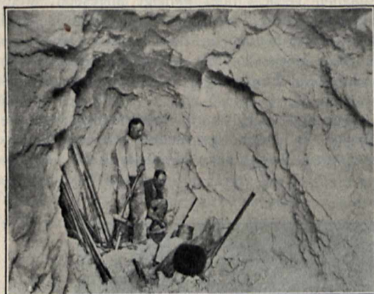
Treiben eines Querschlagcs von einem Versuchsschacht aus, um Erzproben zur Untersuchung zu gewinnen.
