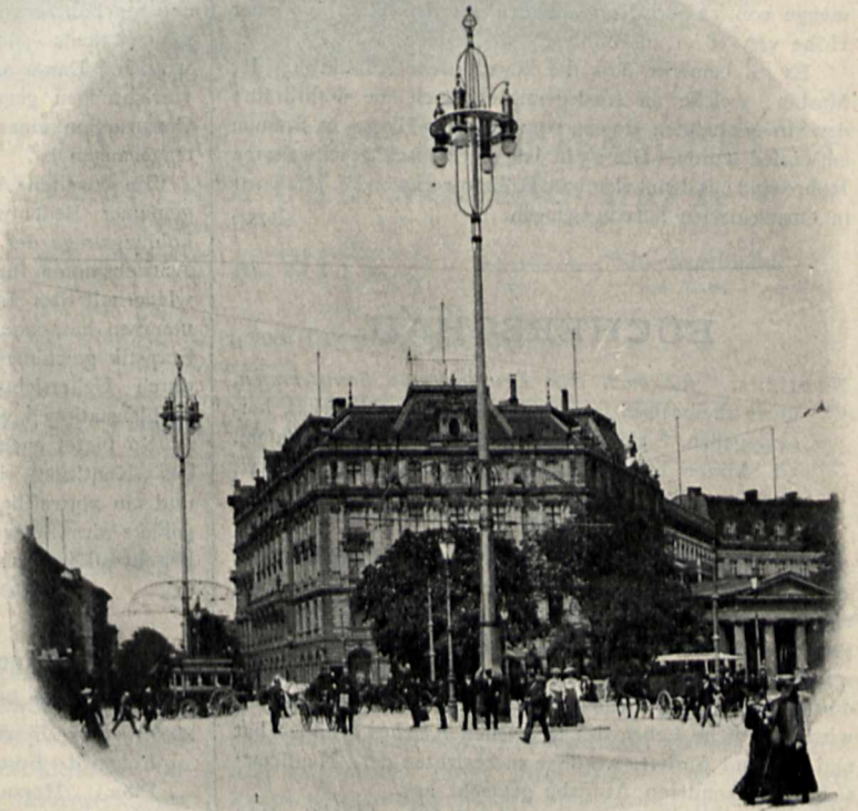
Die neue Beleuchtungsanlage auf dem Potsdamer Platz in Berlin.
