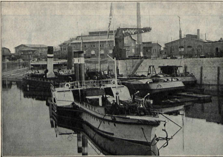
Seitenradschleppdampfer von etwa 300 PS und Hinterradschleppdampfer von etwa 600 PS.
