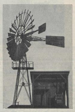
Windrad mit Seitenfahne zum Antrieb landwirthschaftlicher Maschinen. Photographie eines Modells für Unterrichtszwecke an landwirthschaftlichen Lehranstalten.
