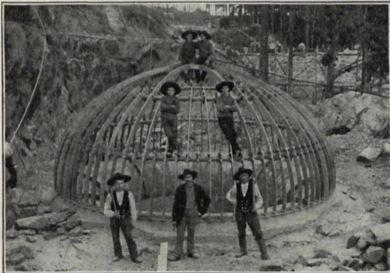
Schutzrechen am Ueberlaufstollen.
