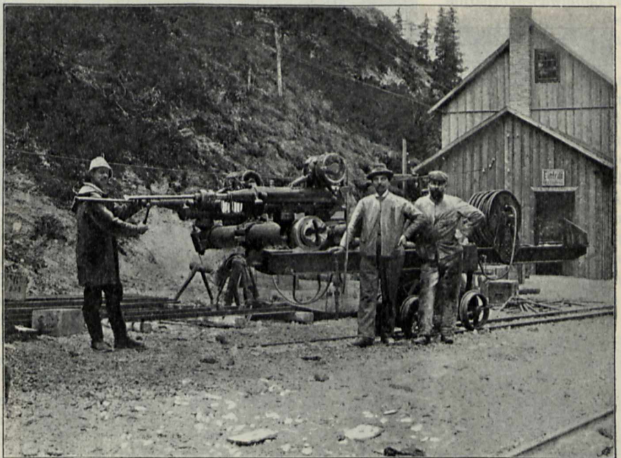
Bohrwagen mit zwei elektrischen 2 PS Kurbelstoss-Bohrmaschinen auf einer horizontalen Spannsäule.
