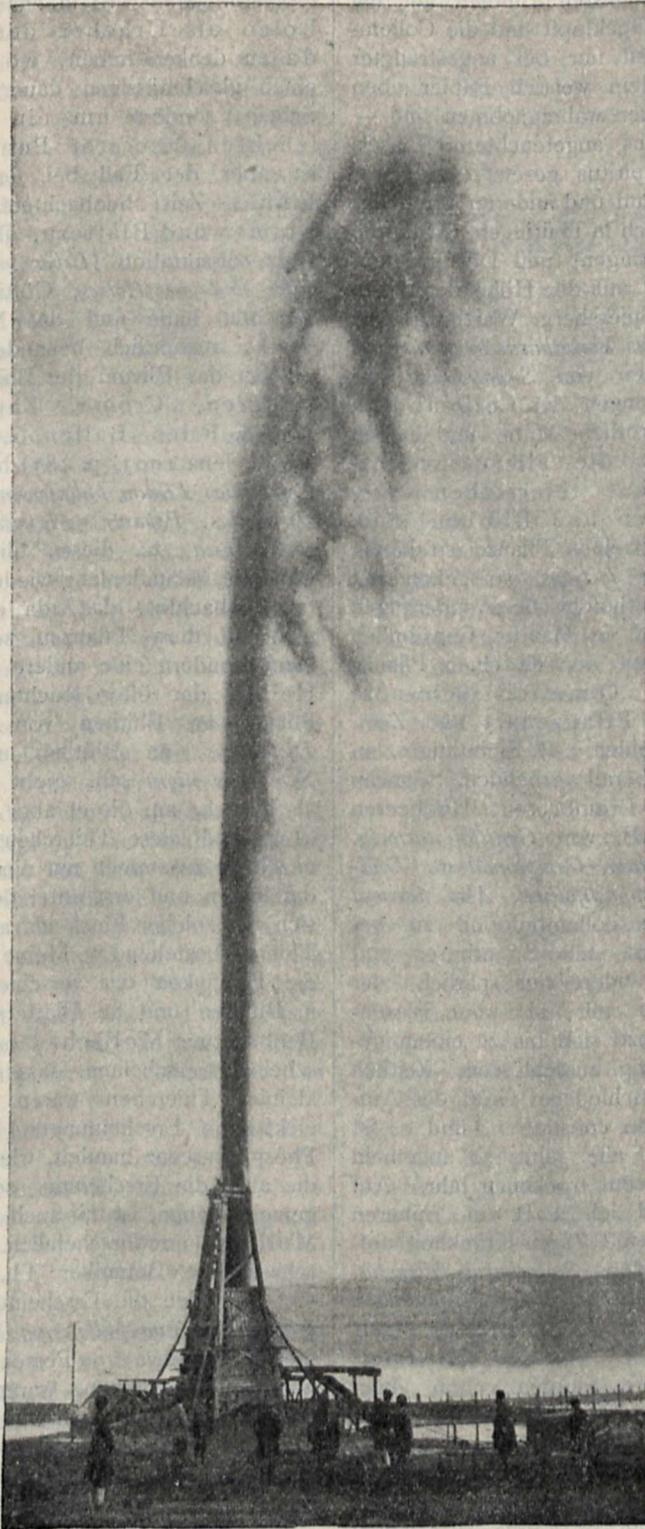
Naphtha nach Zertrümmerung des Bohrthurms in freischlagender Fontäne hoch emporspringend.
