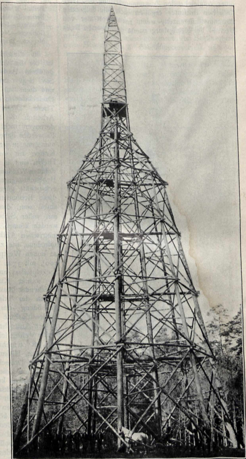
Signalgerüst Tafelbude, gebaut 1901. (Oberförsterei Tafelbude, Kreis Osterode i. Pr. Westpreussisches Haupt-Dreiecksnetz.) Beobachtungshöhe des mittleren Sockelpfeilers 37 m, Gesamthöhe ca. 50 m.
