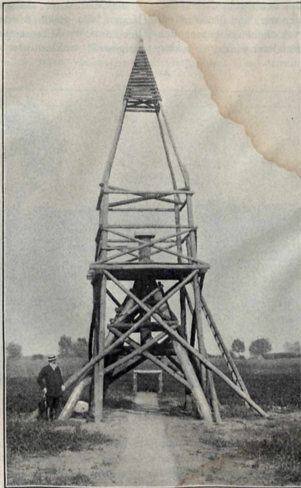
Die Basismessungen: Beobachtungsgerüst über einem Basisendpunkte.
