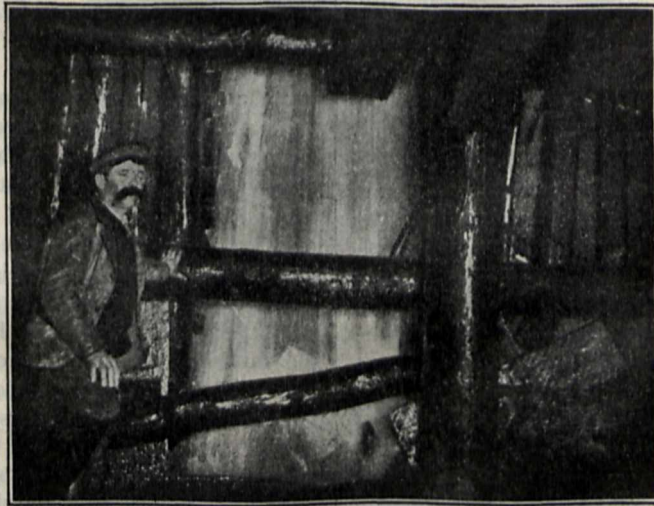
Wassereinbrüche im Simplon-Tunnel: Einbruch einer Quelle in der Galerie II, 3. April 1903.
