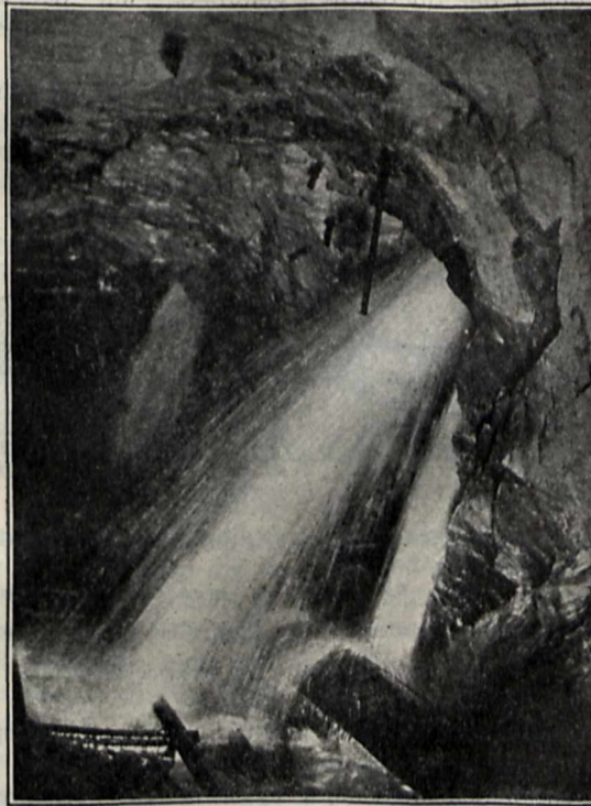
Wassereinbrüche im Simplon-Tunnel: Einbruch einer Quelle in der Galerie II, 11. Mai 1903.
