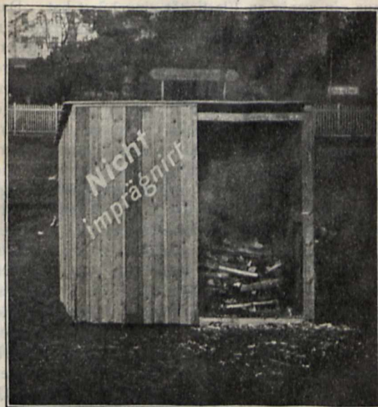
Versuch mit unverbrennlichem Holz: Die Versuchshütten im Moment der Anzündung.
