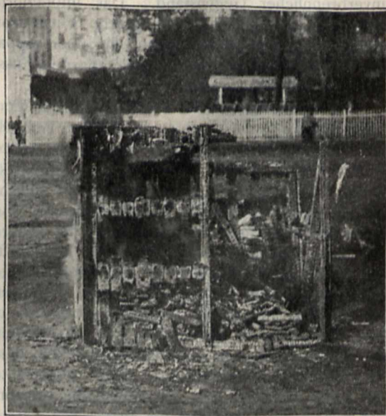
Versuch mit unverbrennlichem Holz: Die Versuchshütten nach einer Brenndauer von 20 Minuten.
