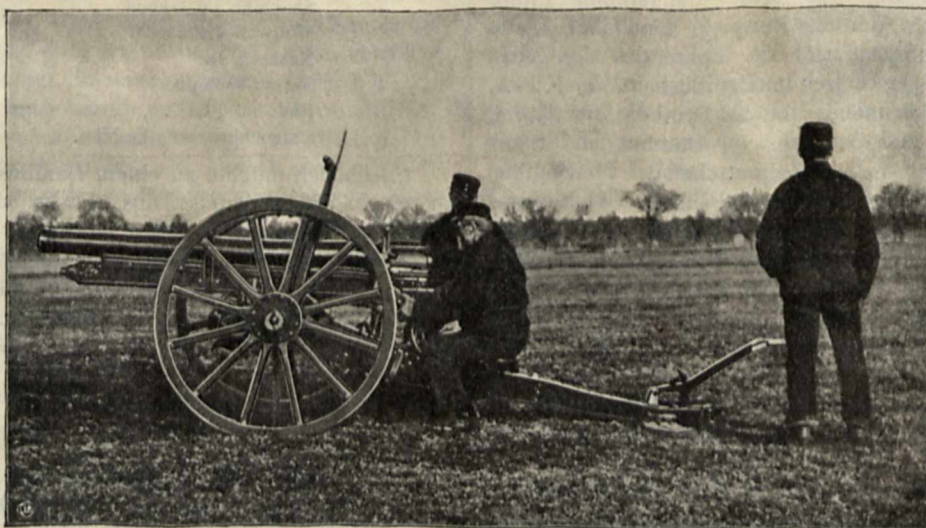
Kruppsches 7,5 cm-Feldgeschütz mit Rohrrücklauf bei den Schiessversuchen in der Schweiz.
