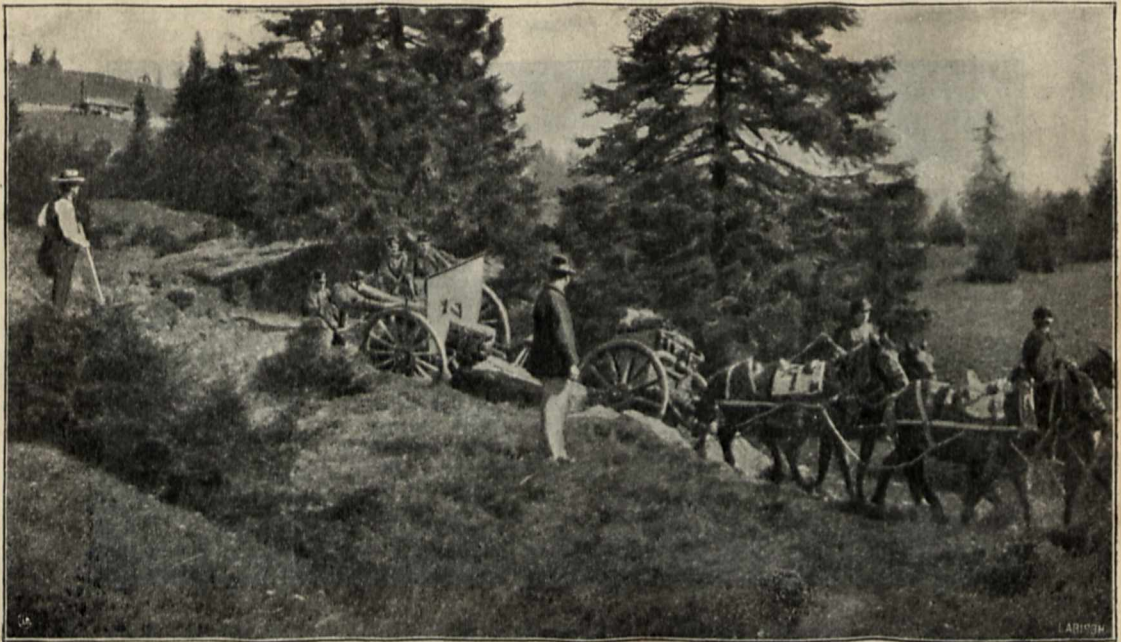
Kruppsches 7,5 cm-Feldgeschütz mit Rohrrücklauf bei den Fahrversuchen in der Schweiz.
