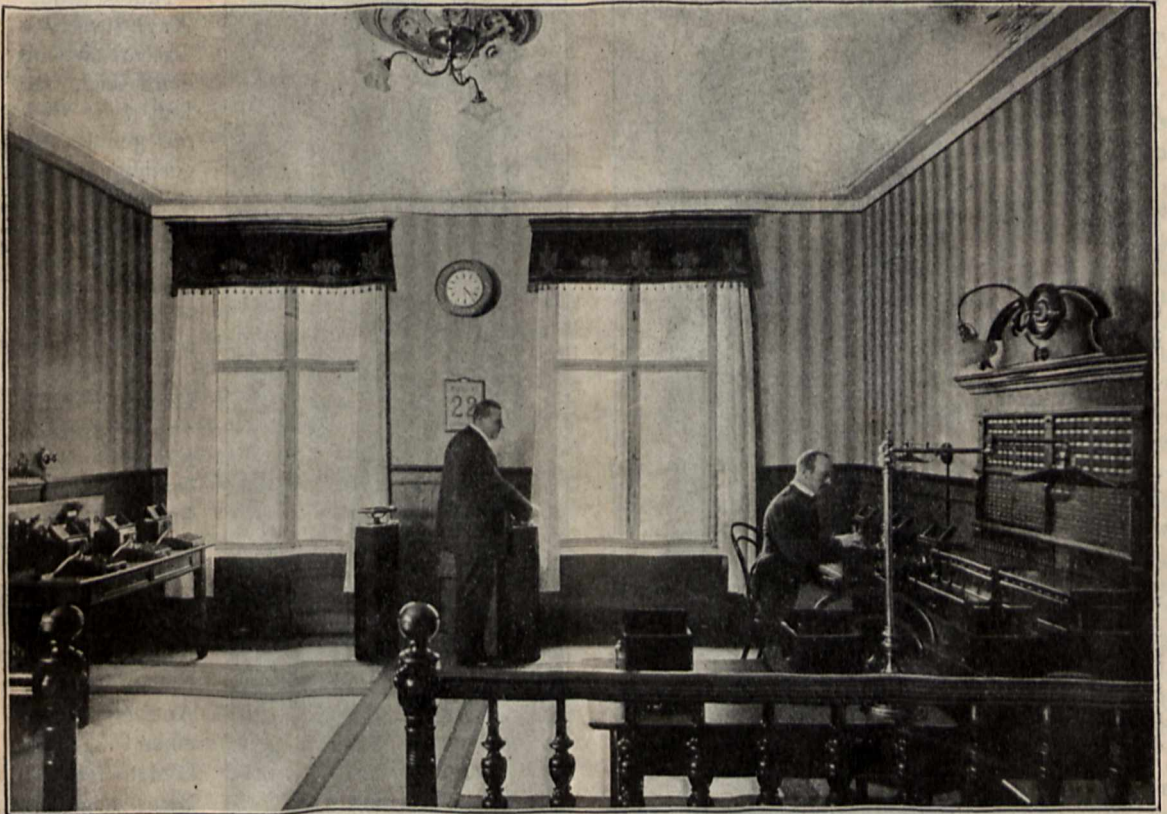
Die Berliner Ferndrucker-Centrale. In der Mitte zwei Gruppenschalter.
