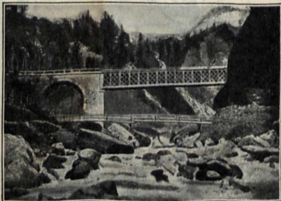
Eisenfachwerkbrücke bei Chedde.
