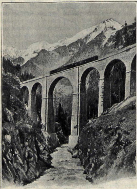
Viaduct von Sainte-Marie. Blick auf die Schneefelder des Montblanc.
