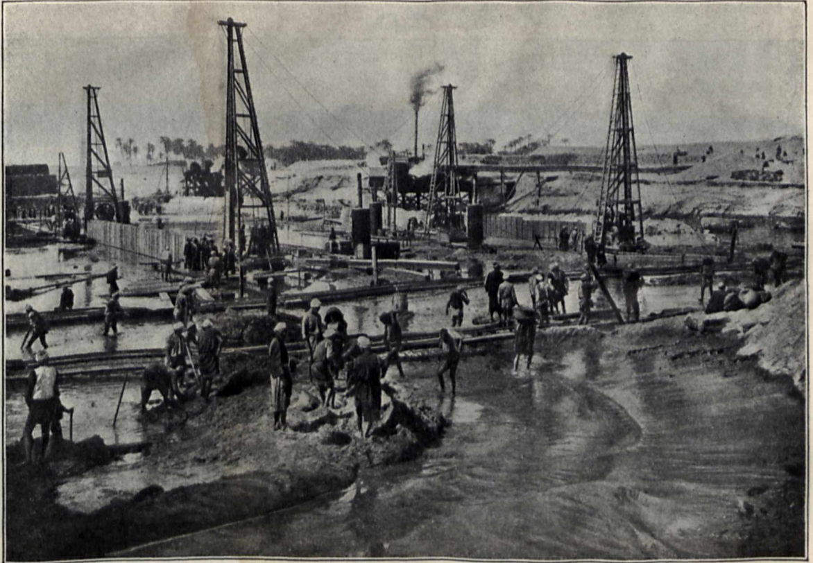
Der Bau des Assiüt-Dammes.
