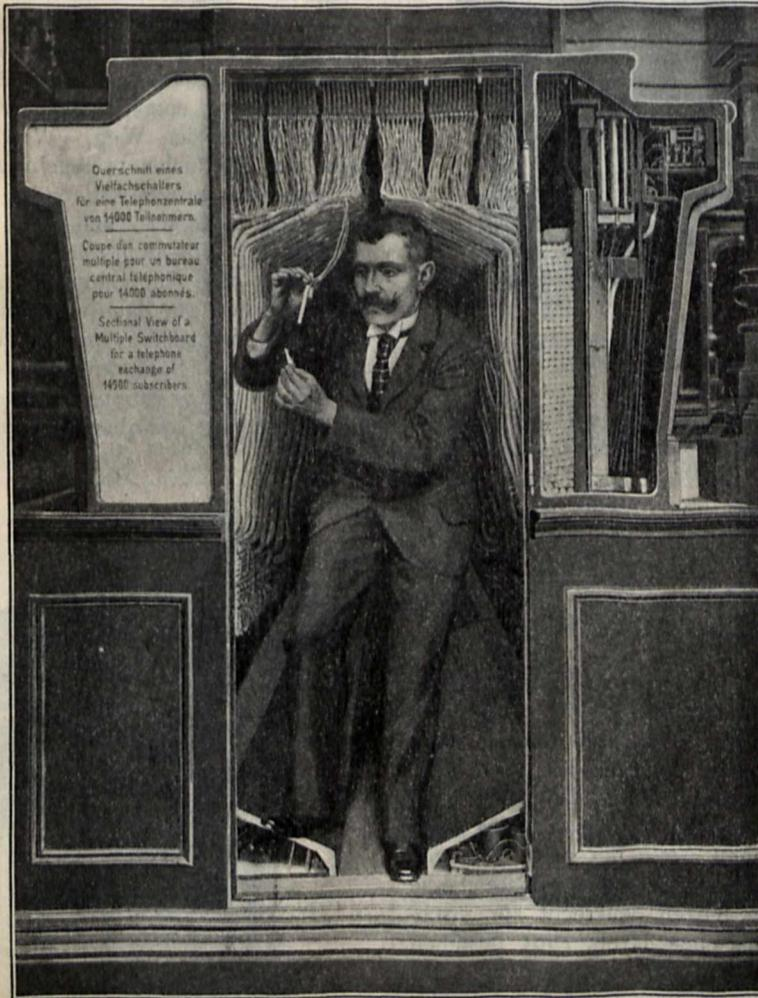
Das neue Fernsprechamt IV in Berlin: Kabelgang unter dem Schalttisch (Durchschnitt).
