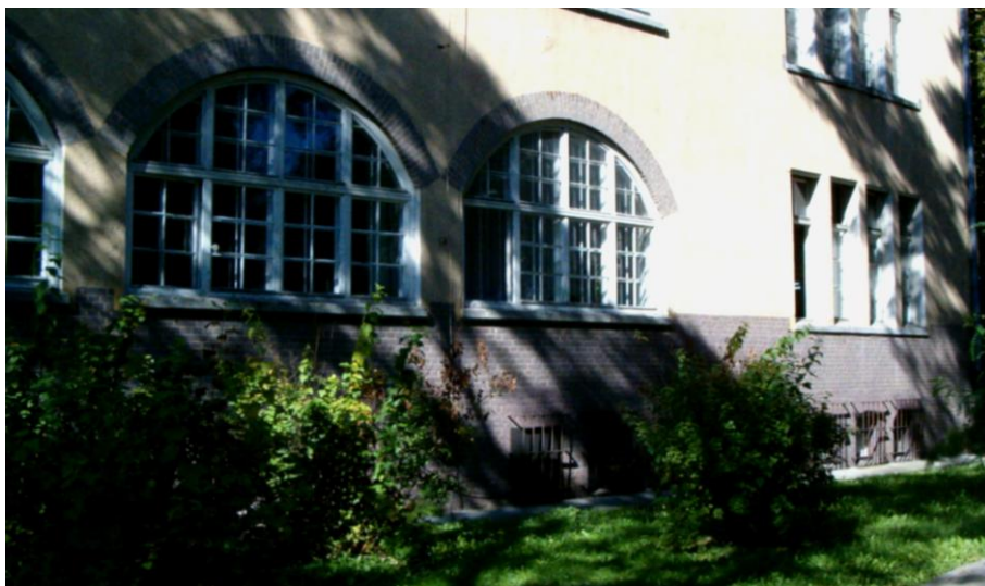
Budynek Biblioteki Głównej AE we Wrocławiu, fot. D. Matysiak.
