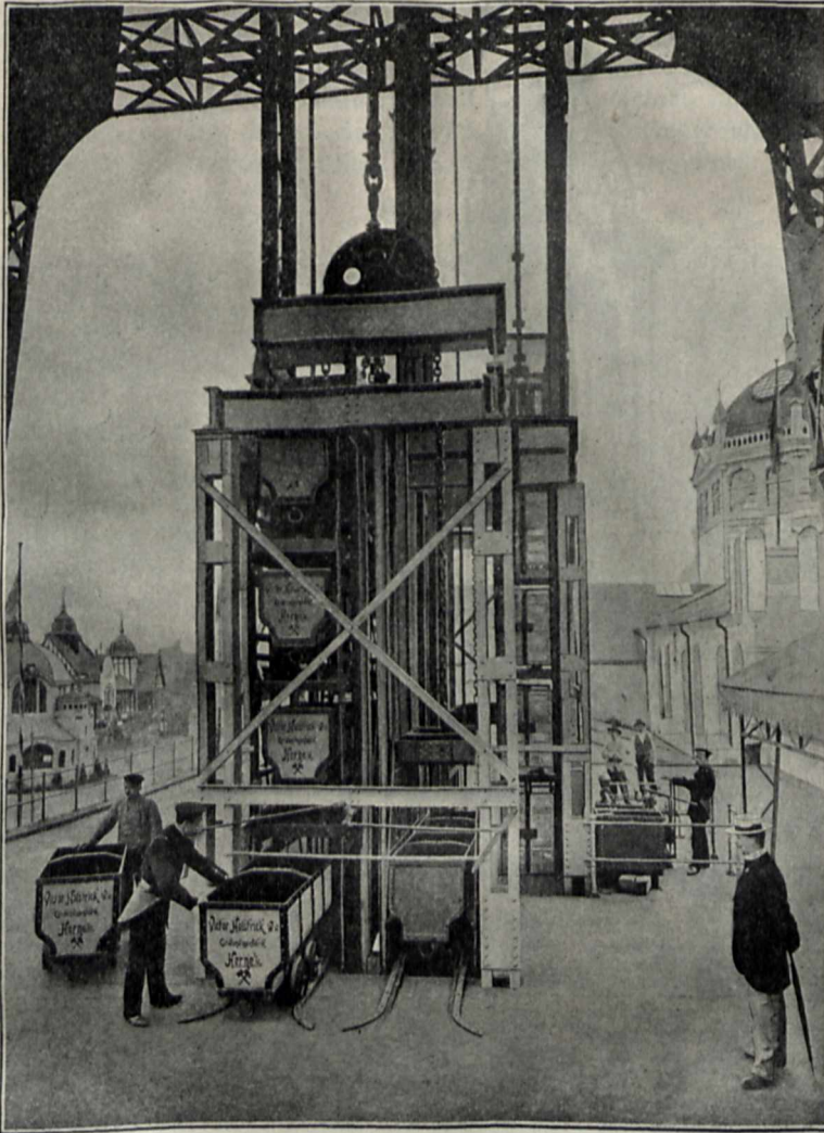
Hilfsfördereinrichtung zum Beladen und Entladen der Förderkörbe auf der Hängebank.
