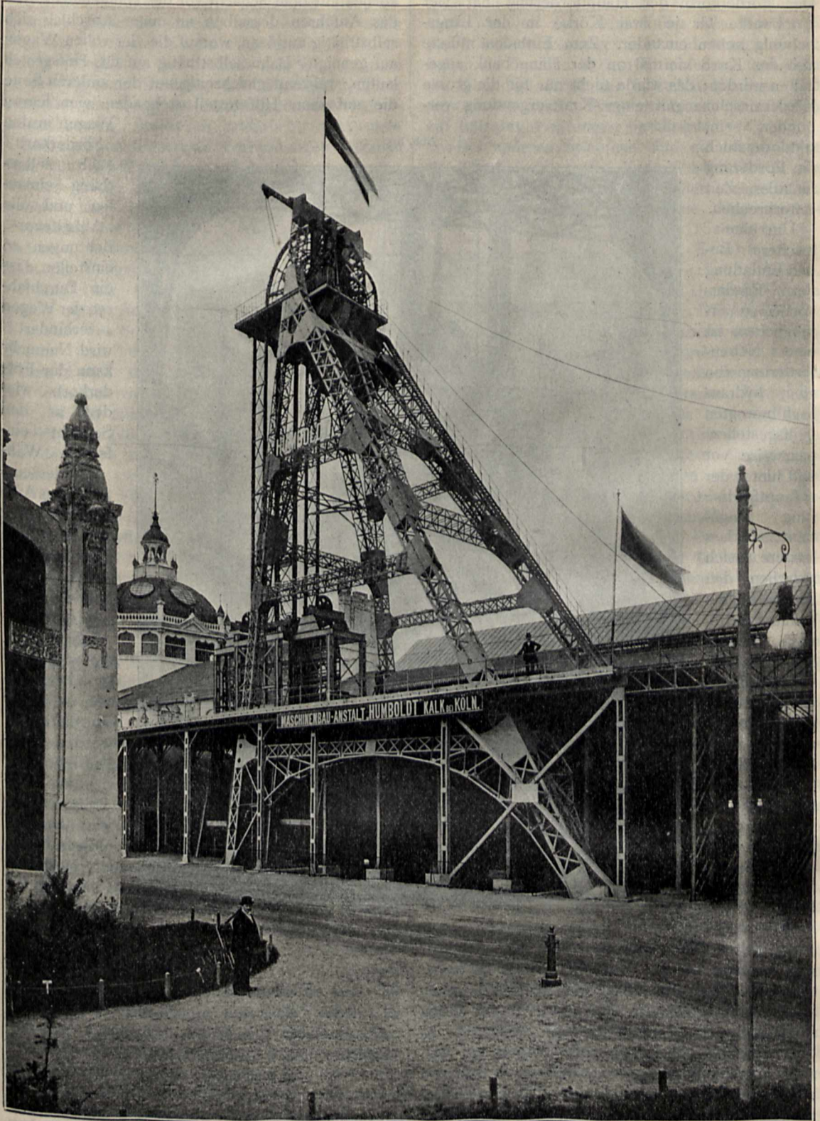
Fördergerüst der Maschinenbau-Anstalt „Humboldt“ in Kalk bei Köln.
