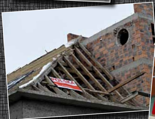
Strefa Kibica (remontowany budynek nr 4 w II kampusie) fot. Sławoj Dubiel
