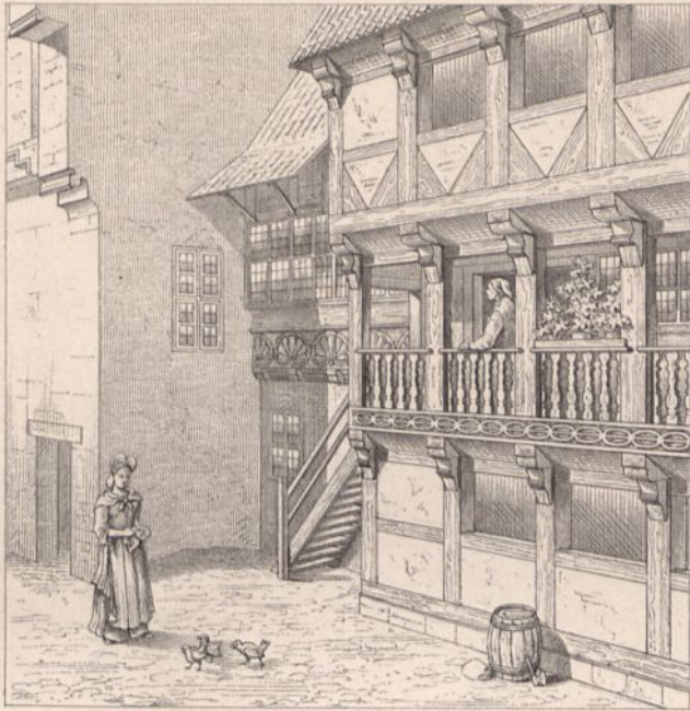
Abb. 1. Hofgebäude. Scharnstrasse Nr. 7. (abgebrochen).
