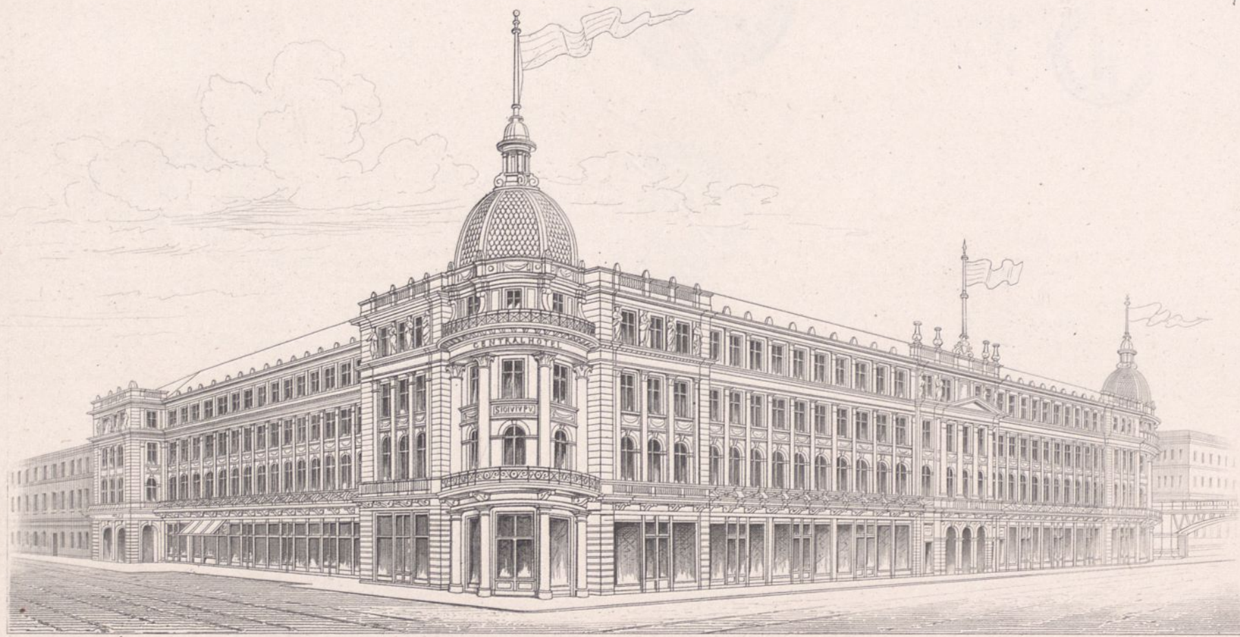
Ansicht des Central-Hotels, Ecke der Friedrich-u. Dorotheen-Strasse.
