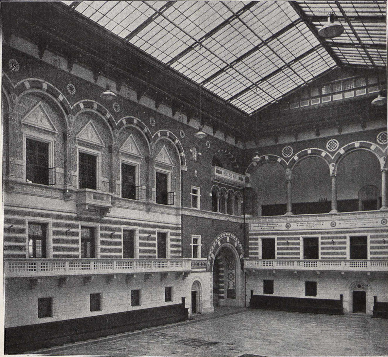
Abb. 9. Blick in die Südecke der großen Halle (Lichthof).
