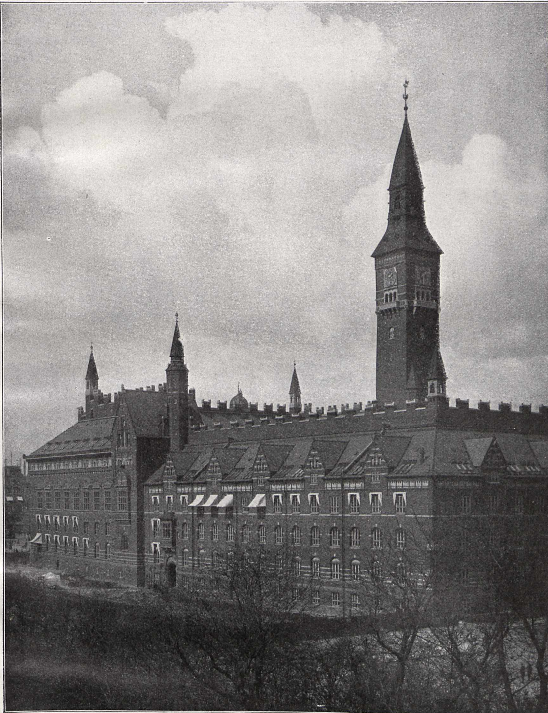
Abb. 2. Ansicht von Südwesten.
