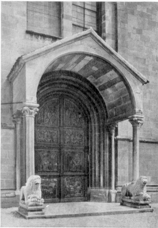
Bozen. – Portal der Pfarrkirche
