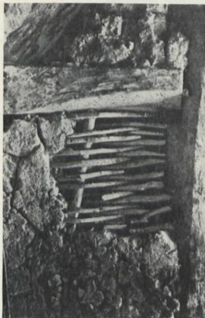
Abb. 16. Teil der Hauswand eines dänischen Hauses mit Flechtwerk und Lehmauffstrich
