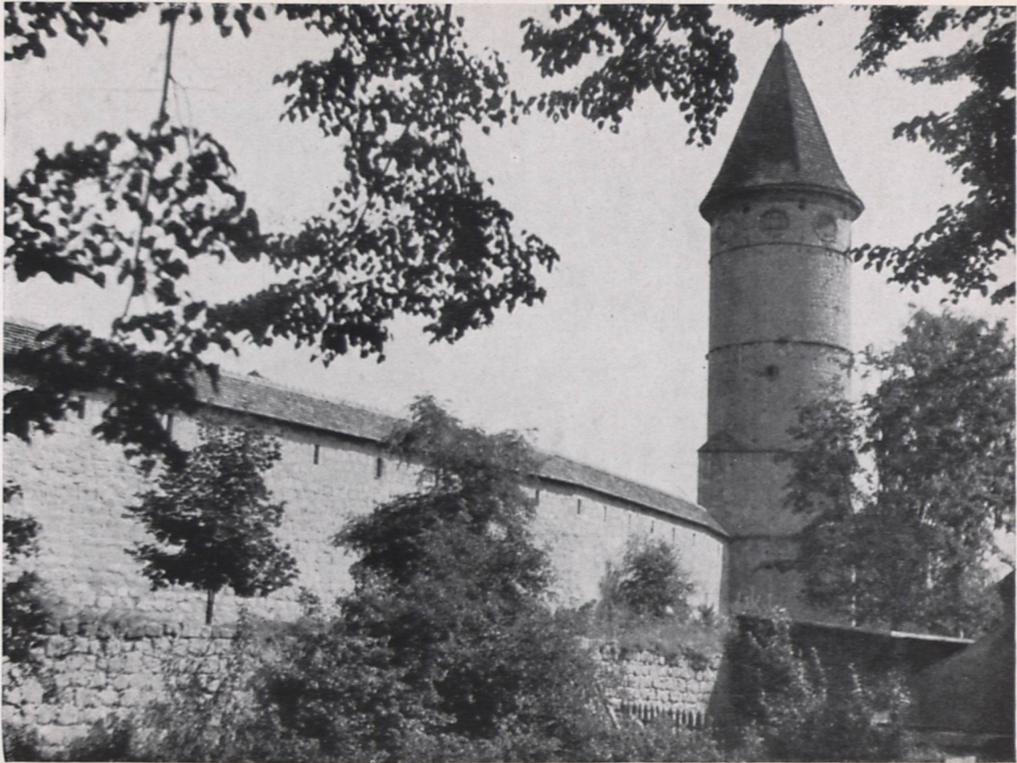
15 Löwenberg, Stadtmauer mit Laubaner Torturm
