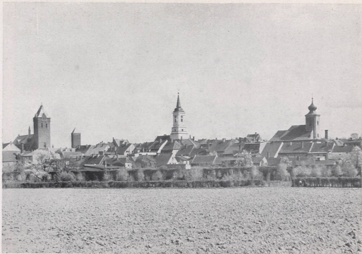
10 Pitschen DC., Stadtmauer von NW.
