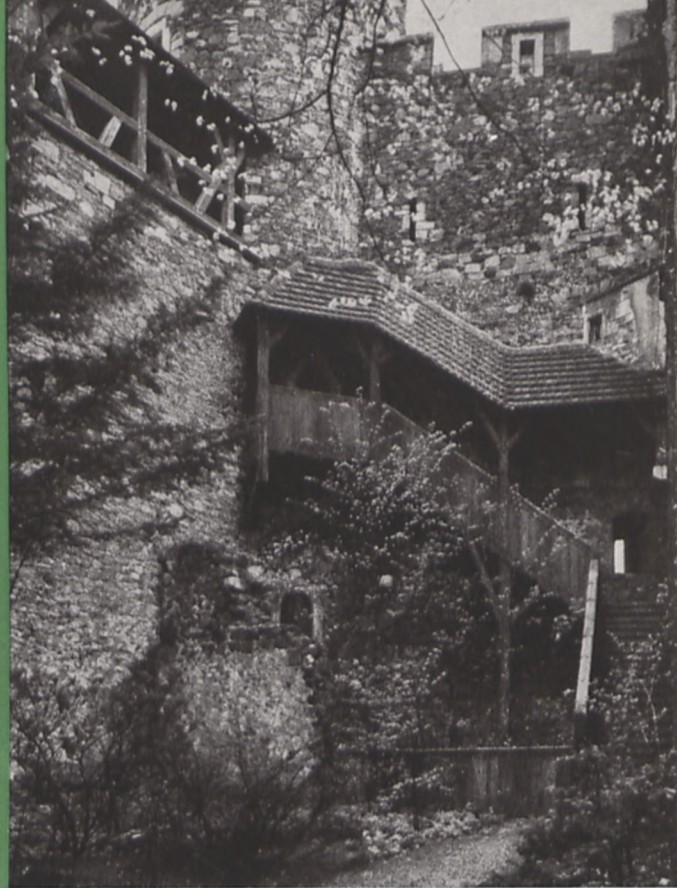
Treppe und Wehgang in der Gröditzburg Fot. Klose
