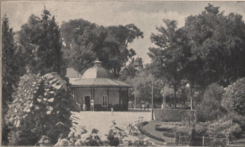
Abb. 26. Aus dem Kurpark in Kudowa.
