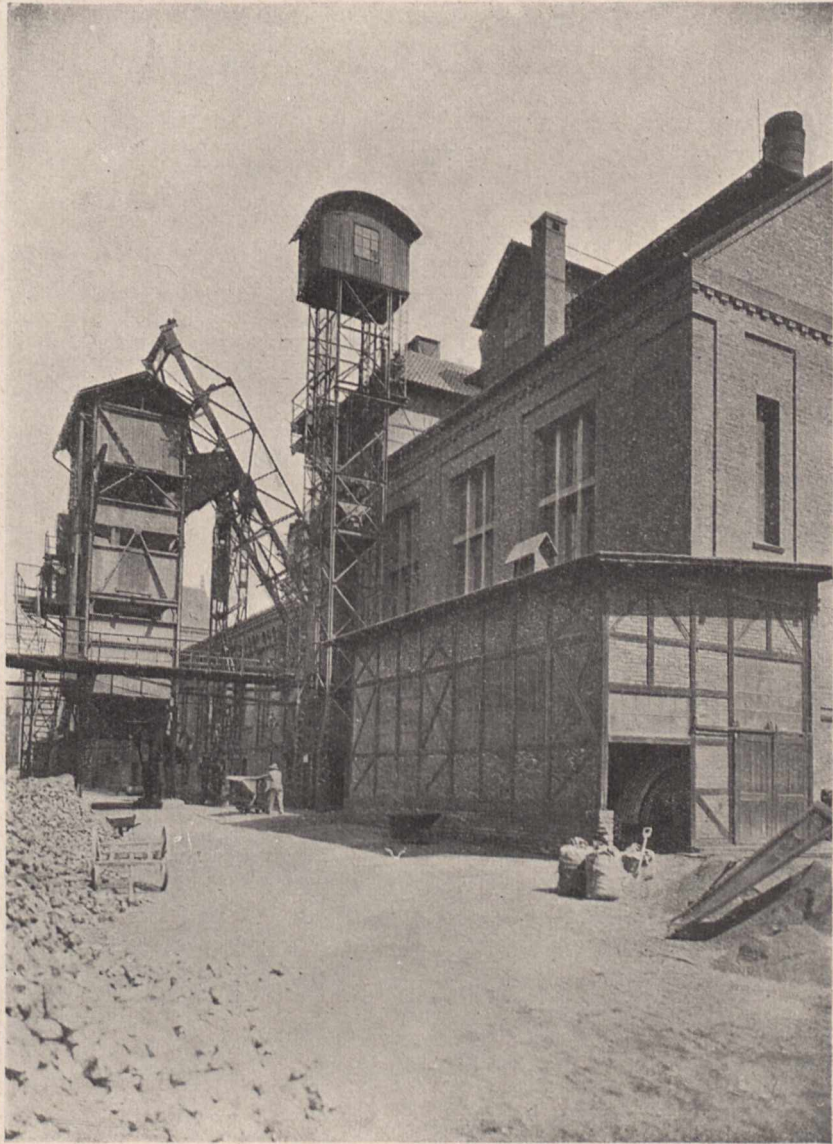
Rys. 6. Dźwigi i sortownia koksu w Gazowni Bydgoskiej.
