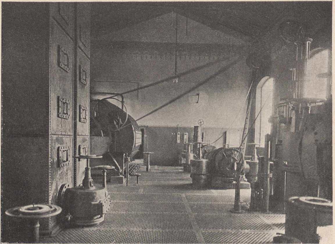
Rys. 9. Aparatownia w Gazowni Bydgoskiej.
