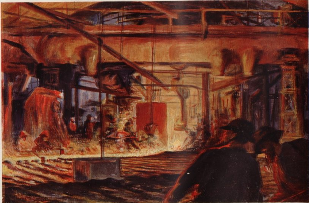
Abstich eines Hochofens in Königshütte Gemälde von A. Dressel
