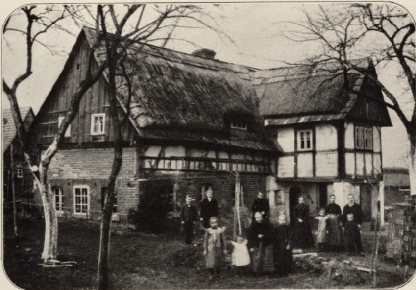
Abb. 13 Haus mit Erker in Friedersdorf, Kreis Lauban
