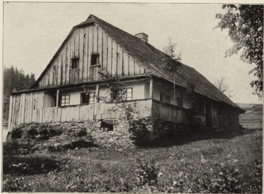
Abb. 7 Haus mit Firhäusla an einer Giebel- und einer Langseite in Oberhillersdorf (Osterr.-Schles. Gegend)
