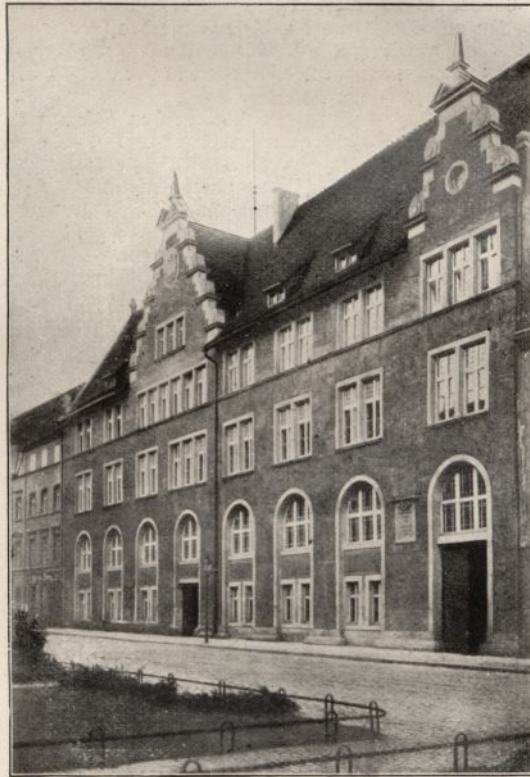
Die neuen Hauptzollämter in Breslau
