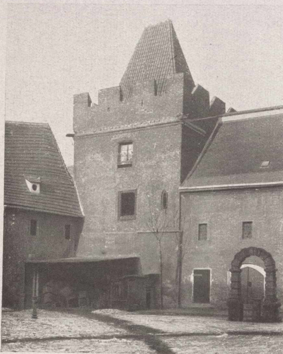
Abb. 5. Breslau, Burgfeld Rest der Befestigung und Renaissance-Brunnen Phot.: Wiese
