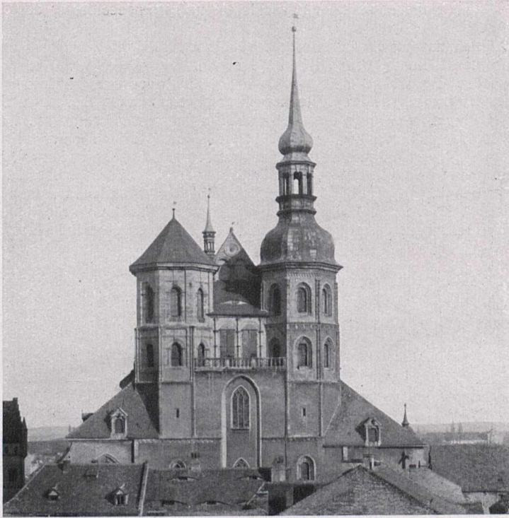
Abb. 99. Görlitz. Westfront der Peterskirche vor Ausbau der Türme 1889
