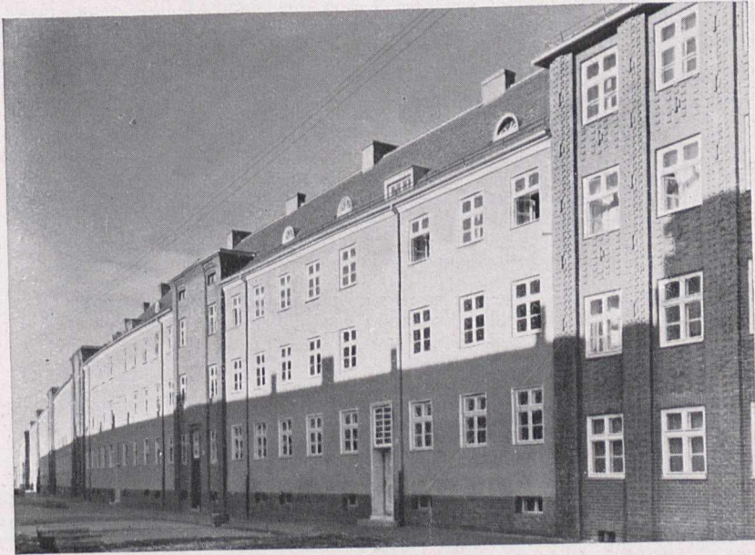
Abb. 62. Siedlung Breslau-Pöpelwitz, Häusergruppe an der Klodnitzstraße Arch. B. D. A. Theo Effenberger, Breslau
