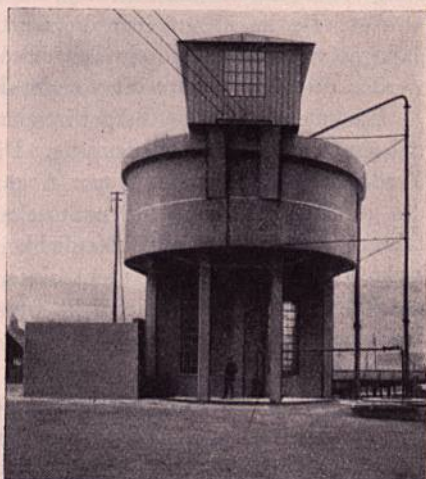
Abb. 62. Hochgestellter Eindicker mit darunterliegender Filteranlage
