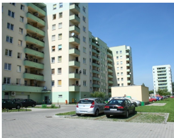
Fot.2. Widok od strony południowej na wnętrze międzyblokowe (fot. aut.)
