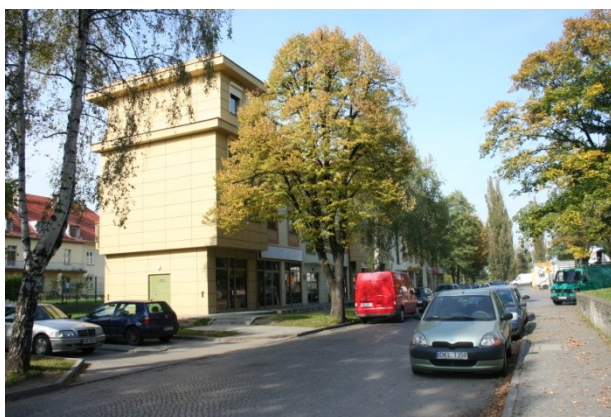
Fot.2. Widok od strony południowo -wschodniej na budynek mieszkalno-usługowy (fot. aut.)
