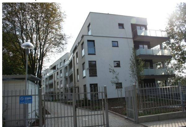
Fot.4. Wejście do zespołu - widok od strony północnej (fot. autor)
