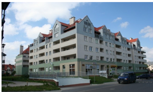
Fot.1. Widok od strony południowej na budynek mieszkalno-usługowy przy ul. Strońskiej (fot. aut.)
