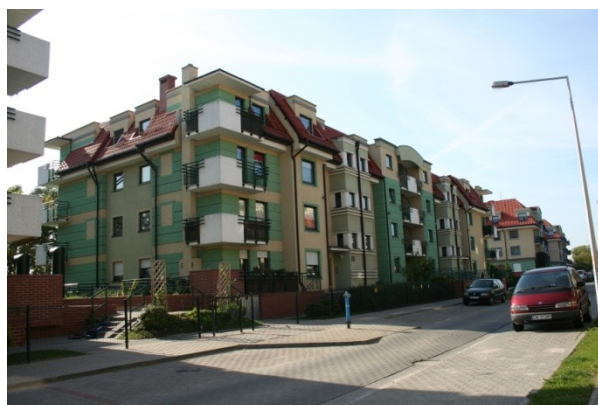
Fot.3. Widok od strony wschodniej na budynek mieszkalny wielorodzinny przy ul. Cukrowej 20-20a (fot. aut.)
