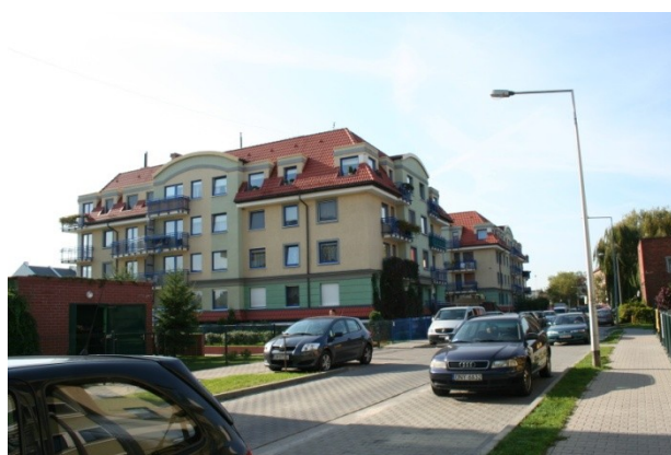
Fot3. Widok na budynek przy ul. Cukrowej 16-16a od strony północno-wschodniej (fot. aut.)
