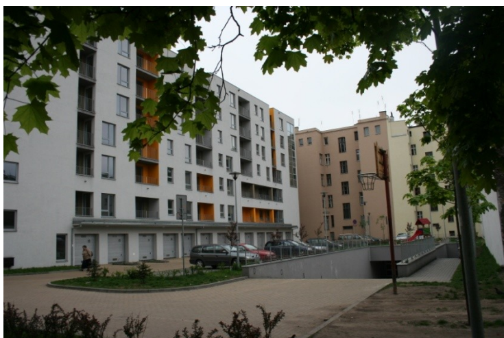
Fot.1. Widok od wnętrza kwartału na budynek mieszkalno usługowy (fot. aut.)
