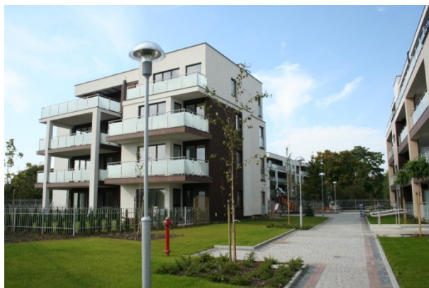
Fot.1. Widok od południa w kierunku wnętrza zespołu budynków ( fot. aut.)
