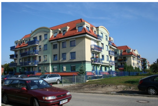
Fot.1. Budynek mieszkalny przy ul.Cukrowej 14 – widok od strony ulicy Migdałowej (od strony zachodniej);(fot. aut.)
