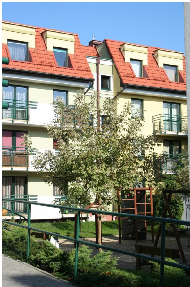
Fot.3. Widok wnętrza zespołu budynków przy ul. Cukrowej 13-15c z placem zabaw (fot. aut.)
