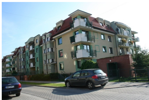
Fot.2. Widok od strony zachodniej na budynek mieszkalny wielorodzinny przy ul. Cukrowej 20-20a (fot. aut.)
