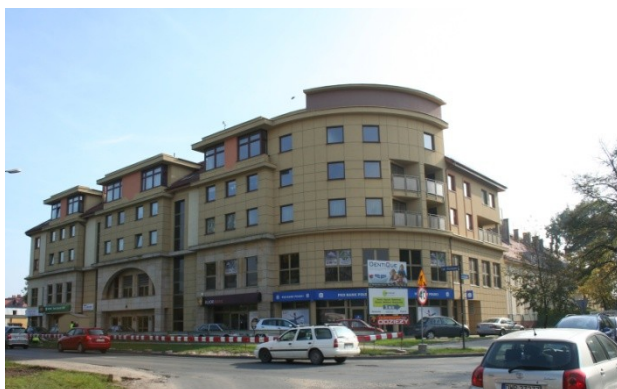
Fot.1. Budynek mieszkalno-usługowy przy ul. Zwycięskiej – Ołtaszyńskiej; widok od strony północnej. (fot. aut.)
