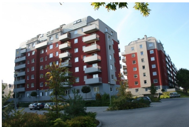
Fot.1. Widok od strony południowej na zespół budynków mieszkalnych (fot. aut.)
