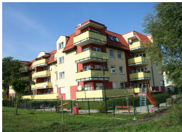
Fot.2. Widok od strony południowej na budynek mieszkalny wielorodzinny przy ul. Cukrowej 22-22a, na pierwszym planie prowizoryczne miejsce wspólne - plac zabaw (fot. aut.)
