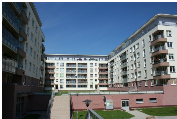
Fot.2. Widok wnętrza zabudowy z dachem zielonym na garażu wielostanowiskowego (fot. aut.)
