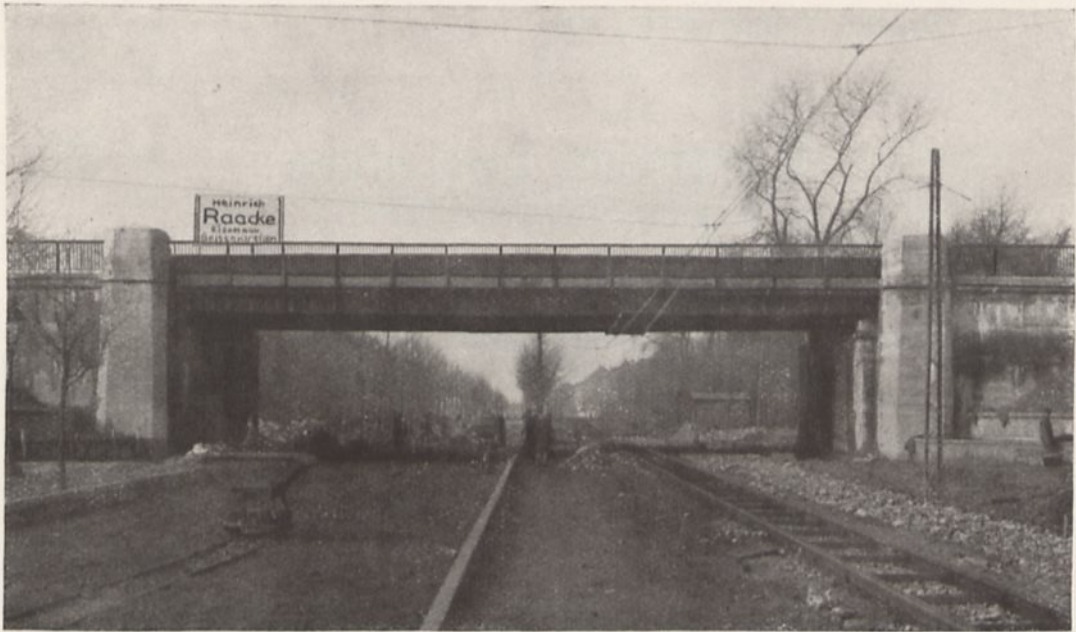
Brücke Reichsbahnunterführung Zeppelinallee
