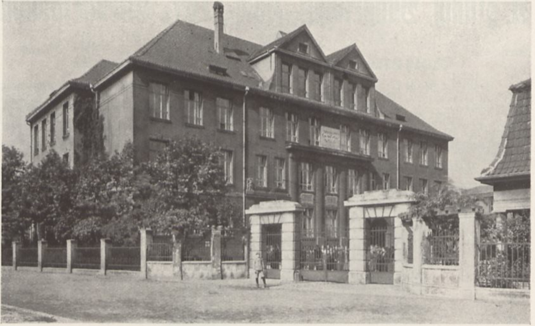
Städt. Gewerbeschule Gelsenkirchen. (Ausführung: A. Stauch, Baugeschäft, Gelsenkirchen.)
