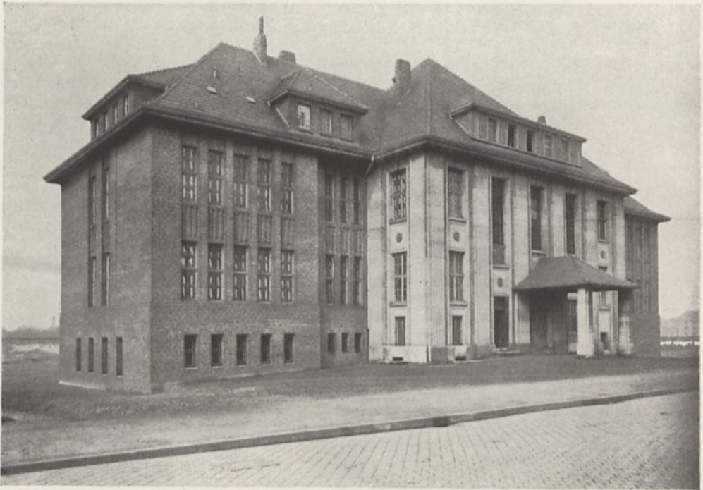
Verwaltungsgebäude Akt.-Ges. für Chem. Industrie, Gelsenkirchen. (Ausführung: A. Stauch, Baugeschäft, Gelsenkirchen.)
