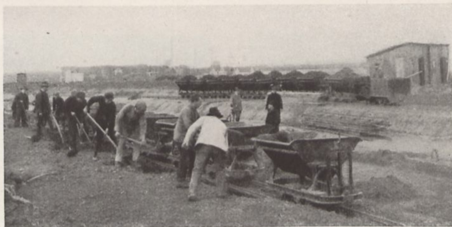
Ausbau der Verbandstraße Gelsentkirchen-Sattlingen.
