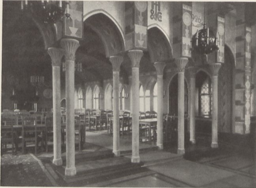
Teilansicht vom Speisesaal im Verwaltungsgebäude der Fa. Henkel & Co., Düsseldorf. Säulenpartie, Fensterbänke, Konsolen usw. in Kunstdolomitstein ausgeführt.
