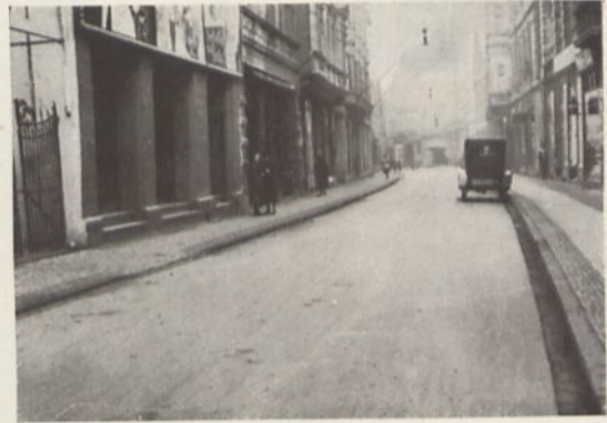
Asphaltierung der Hochstraße Gelsenkirchen.
