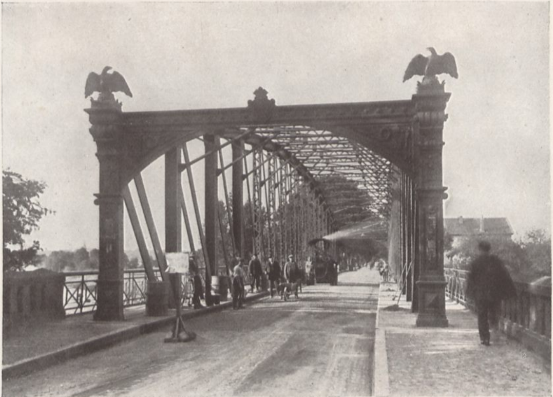
Kaltasphalt-Straßenbau in Burg bei Bremen
