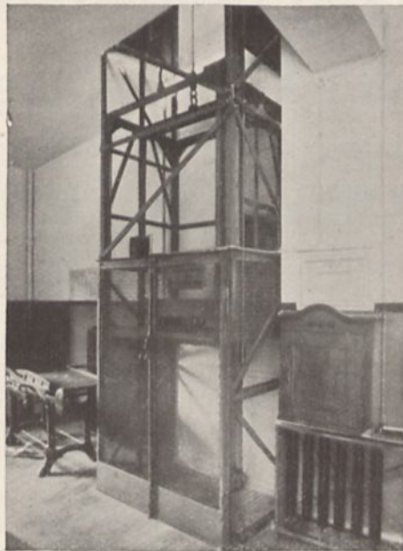
Ein von der Firma ausgeführter elektr. betriebener Lastaufzug für 500 kg
