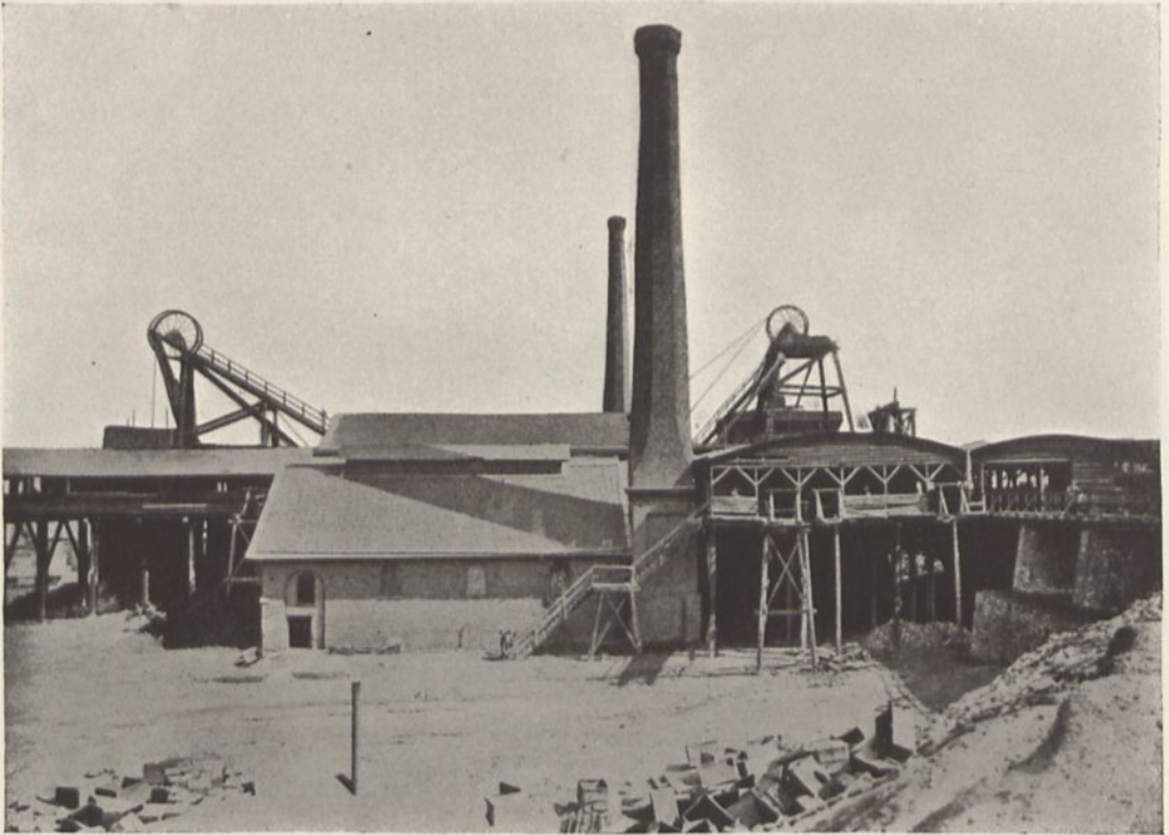
Erste Schachtanlage der Zeche Hibernia
