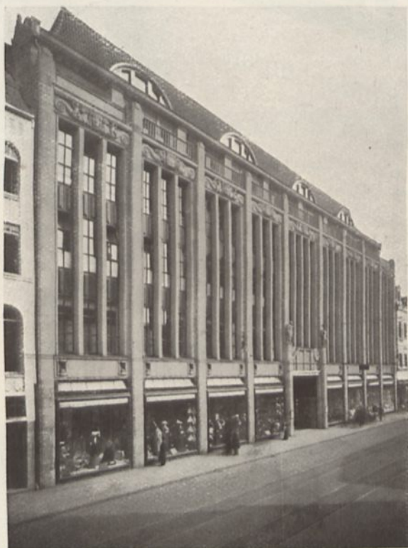
Ein von der Firma ausgeführter Bau
