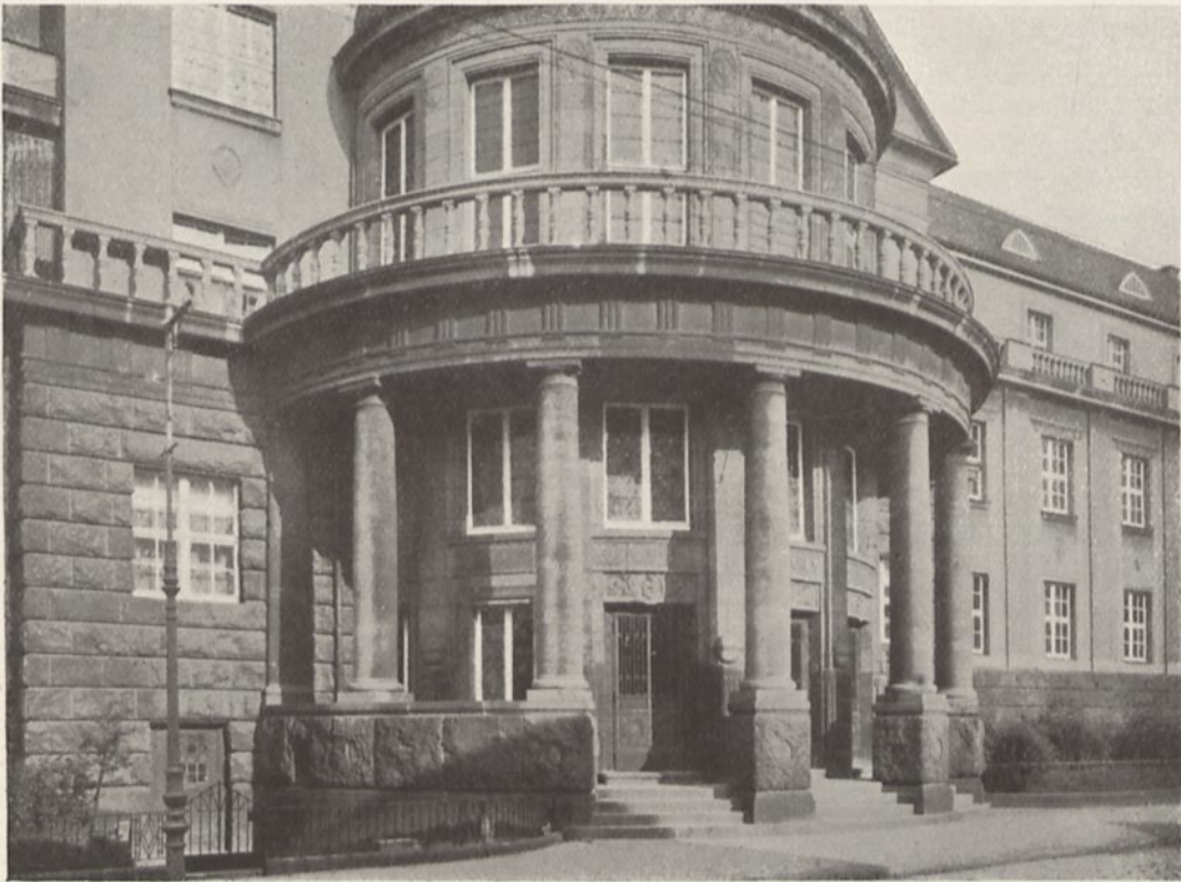
Gymnasium: Ansicht von der Schalker Straße
