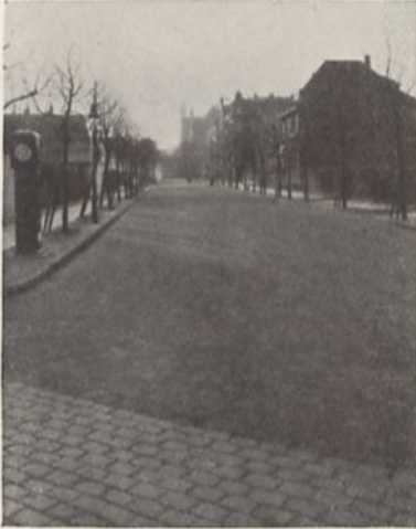
Pflasterung der Doerwegstraße in Gelsenkirchen, ausgeführt im Jahre 1925 für die Stadtverwaltung Gelsenkirchen.
