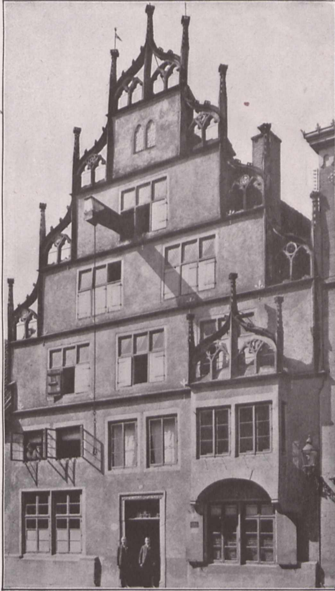
Lemgo. Wippermansches Haus
