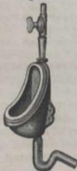
1153 bestehen aus emaillirtem Gusseisen oder Fayence; die Spülung erfolgt durch 13 mm weiten Hahn und Spritzblech-Vertheilung; beim Abfluss dienen 50 mm weite Traps. —
