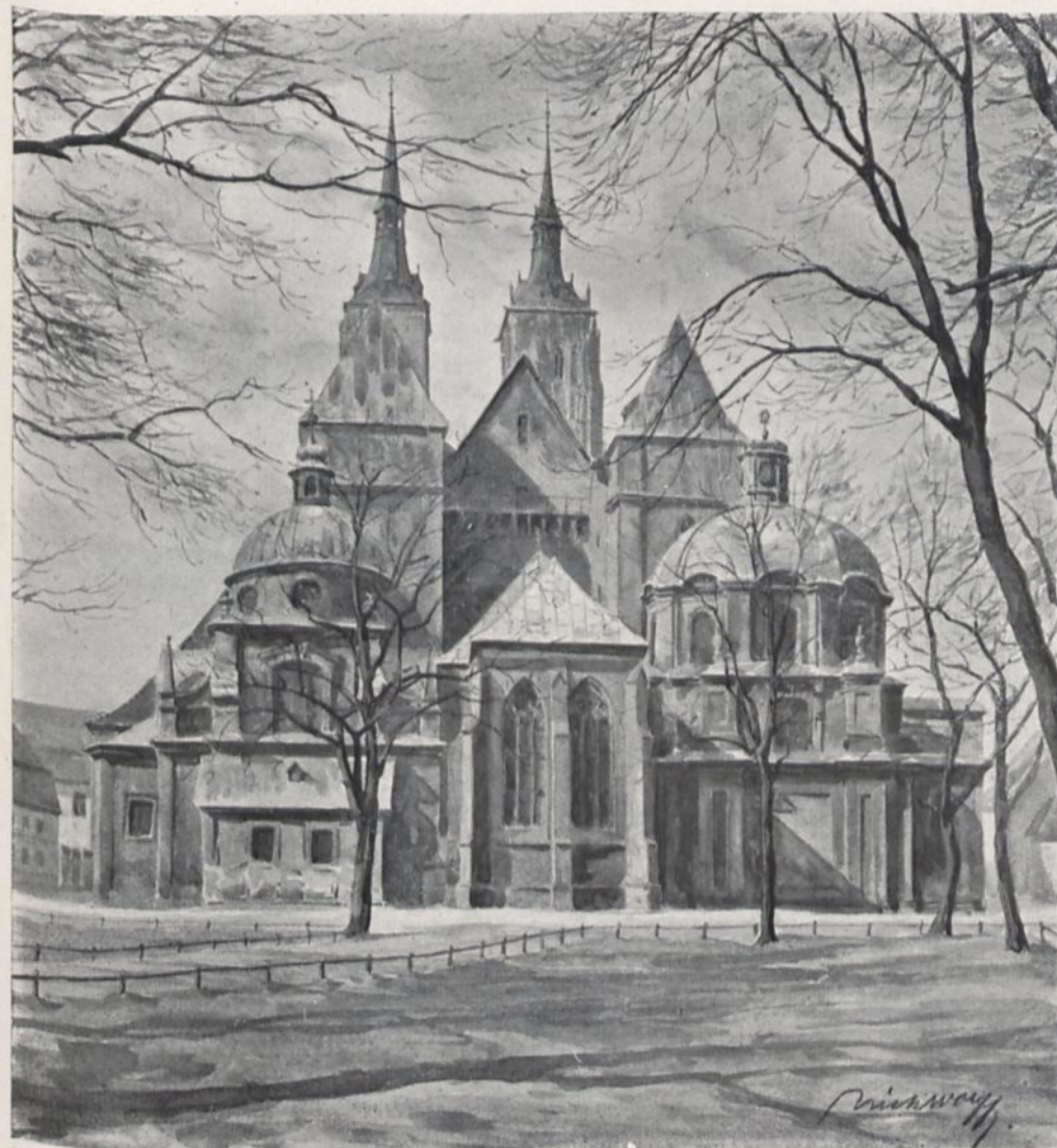
Breslau, Dom, Ostseite
