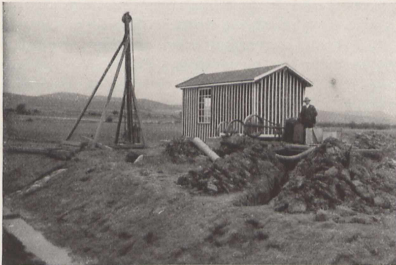
Dränagearbeiten auf den Kammergutwiesen in der Flur Gerstungen. Die im Bau befindliche Pumpstation im Jahre 1928
