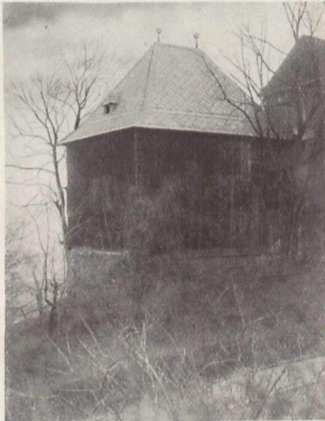
Haus am Glockenturm Eisenach. 1928 umgedeckt mit Dachschiefer aus dem Schieferbruch Fa. C. Oertel, Lehesten
