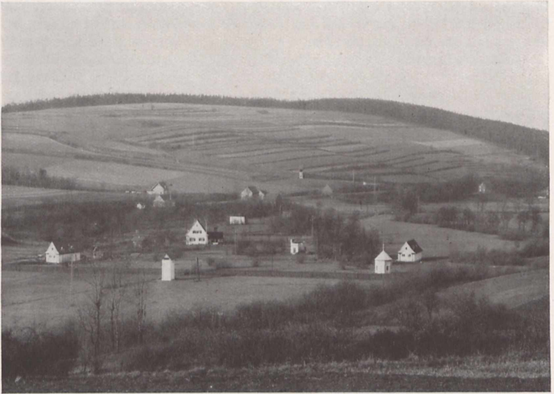
Gesamtansicht des Quellgebietes Farnroda mit den neu erbauten Pumpstationen.
