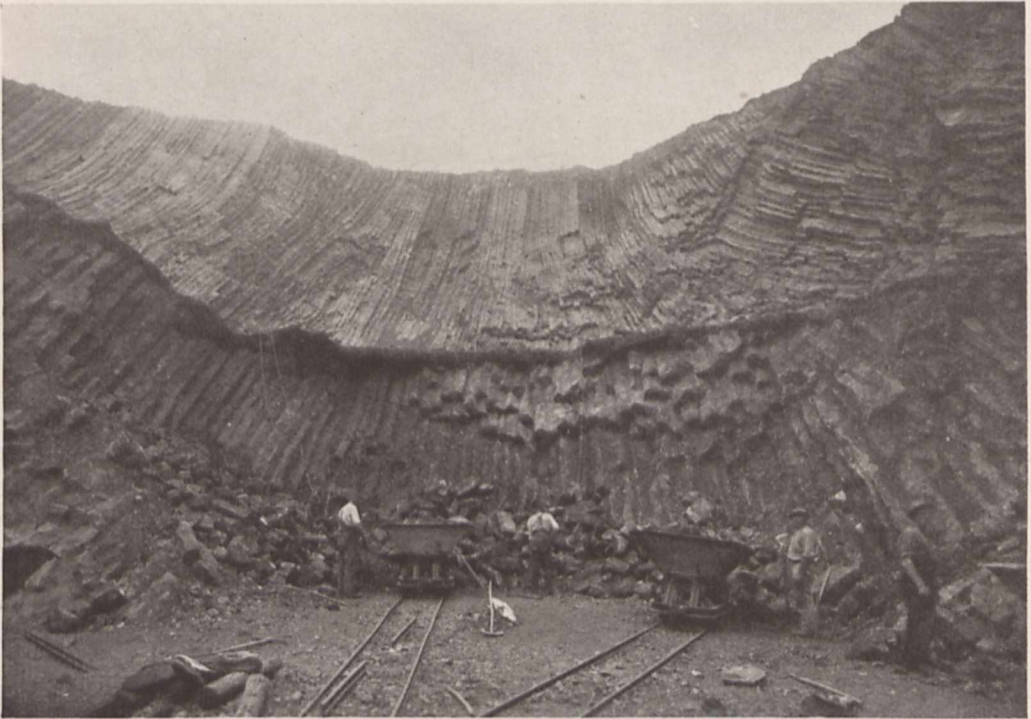
Blick vom Tunnelausgang Pilgramsdorf. Tunnellänge 200 m, Breite 4 m, Höhe 3 m
