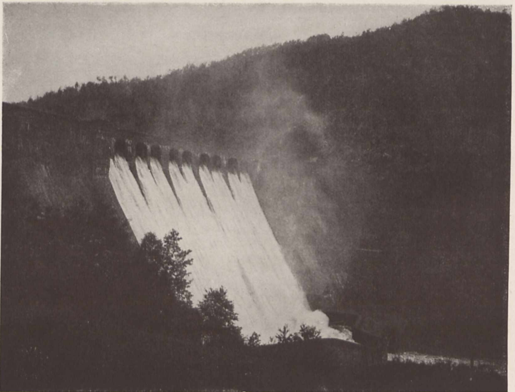
Talsperre bei Breitenhain. (Abb. 4.) Erbaut 1912—1917. Stauraum 8 Millionen cbm. Länge der Sperrmauer 230 m. Höhe 44 m. Breite unten 29 m. Im Kraftwerk: 3 Turbinen — 2 \times 720 + 290 P. S. = 1730 P. S. 3 Drehstromerzeuger = 1645 kVA. Jahresleistung: 4 Millionen Kilowattstunden
