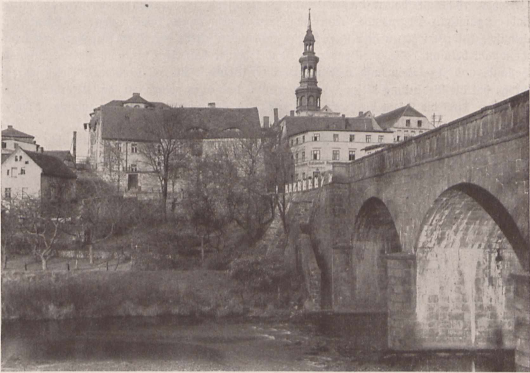
An der Queistalbrücke in Greiffenberg
