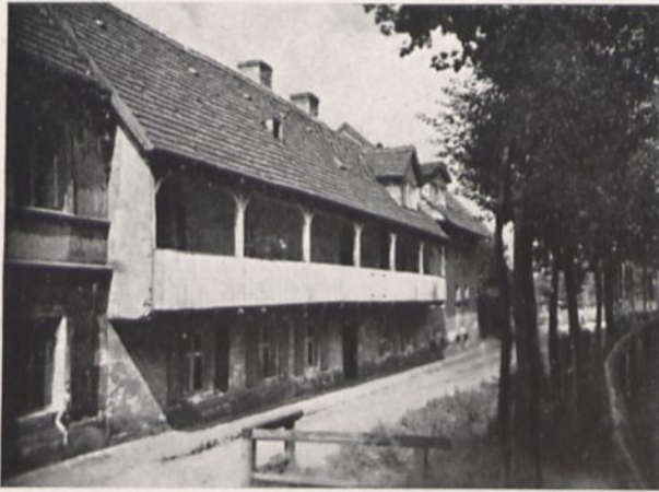
An der Lazarettstraße — ehemalige Torwächterhäuser
