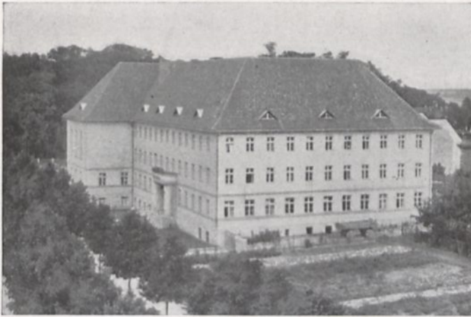
Kreishaus Oels. Ausführung der Dachdecker-, Klempnerarbeiten u. Blitzschutzanlagen
