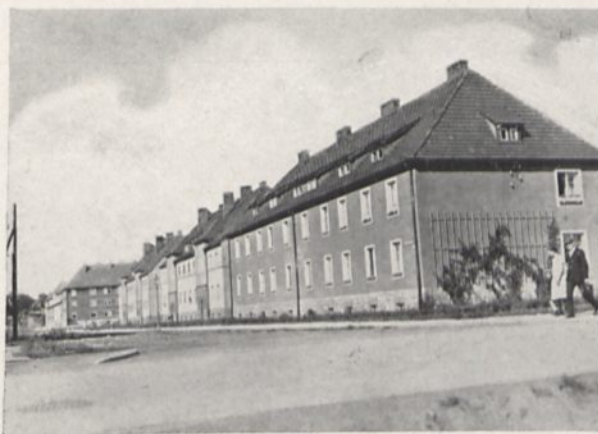
Städtische Wohnhäuser an der Friedrich Ebert-Straße
