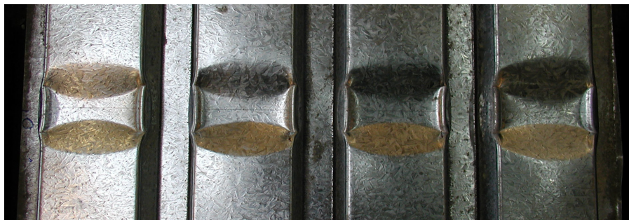
Rys. 2.4. Przykładowa postać zniszczenia blachy faldowej pierwszej generacji w wyniku działania obciążenia skoncentrowanego
