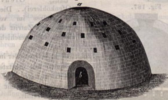
Thüre *b* eingeführt; von der Thüre bis in die Mitte der Sohle geht die Zündgasse. Mit Ausnahme eines geringen Theiles der Thüröffnung und des Loches *a* werden alle Oeffnungen vermauert und erst bei dem Kohlenziehen wieder geöffnet. Nachdem das Holz genügend in Brand gerathen ist, werden *b* und *a* verschlossen. Die an dem oberen Ende des Meilerofens befindlichen kleinen Oeffnungen entsprechen den Rauchlöchern des Meilers.
