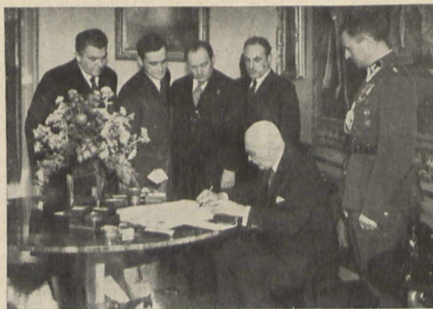
Pan Prezydent R. P. kładzie pierwszy podpis na akcie erekcyjnym budowy nowych gmachów Wydziału Mechanicznego i Elektrotechnicznego Politechniki Lwowskiej w czasie audiencji na Zamku delegacji Komitetu Budowy.
