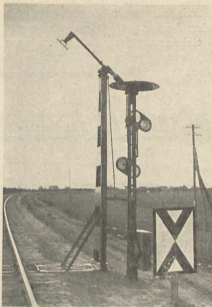
Rys. 1. Sygnał wskazujący wolną drogę z podniesionym ramieniem urządzenia Koflera.
