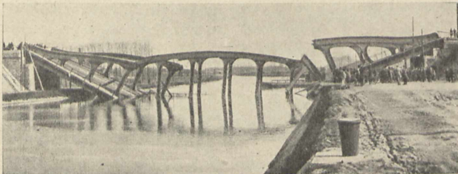
Rys. 2. Most po załamaniu się.
