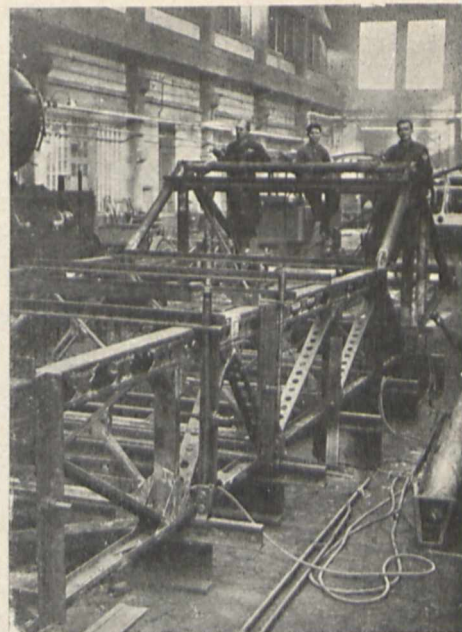
Rys. 7. Montaż i spawanie szkieletu głównego na podstawkach. Wszystkie mocowadła i przyrządy są jasno widoczne. Dwóch acet.-tl. spawaczy spawa jednocześnie węzły B-B.
