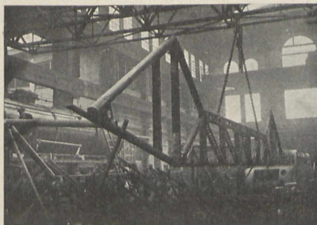
Rys. 6. Przenoszenie dźwignicą półramy szkieletu.
