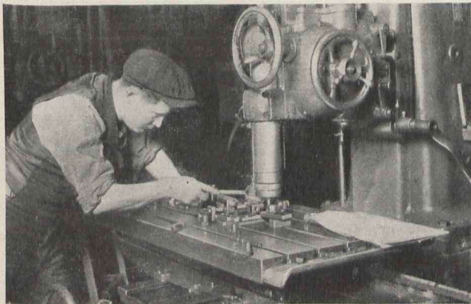
Rys. 3. Zalewanie tulejki w przyrządzie wiertarskim.
