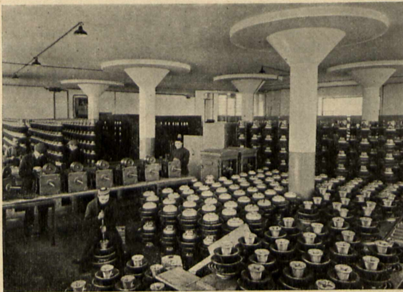
Rys. 5. Montaż odłączników 150 kV.
