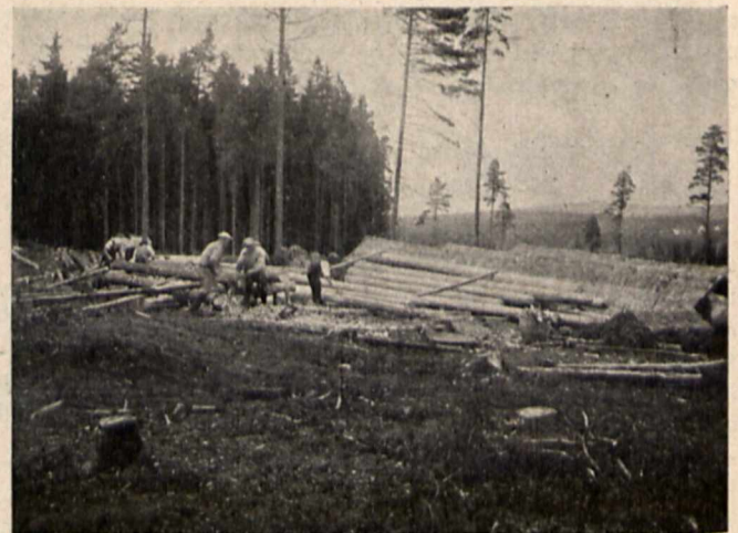
Rys. 8. Nasycanie metodą „Osmoza”
