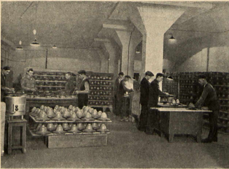
Rys. 2. Montaż izolatorów wiszących w fabryce K. Szpotański i S-ka.
