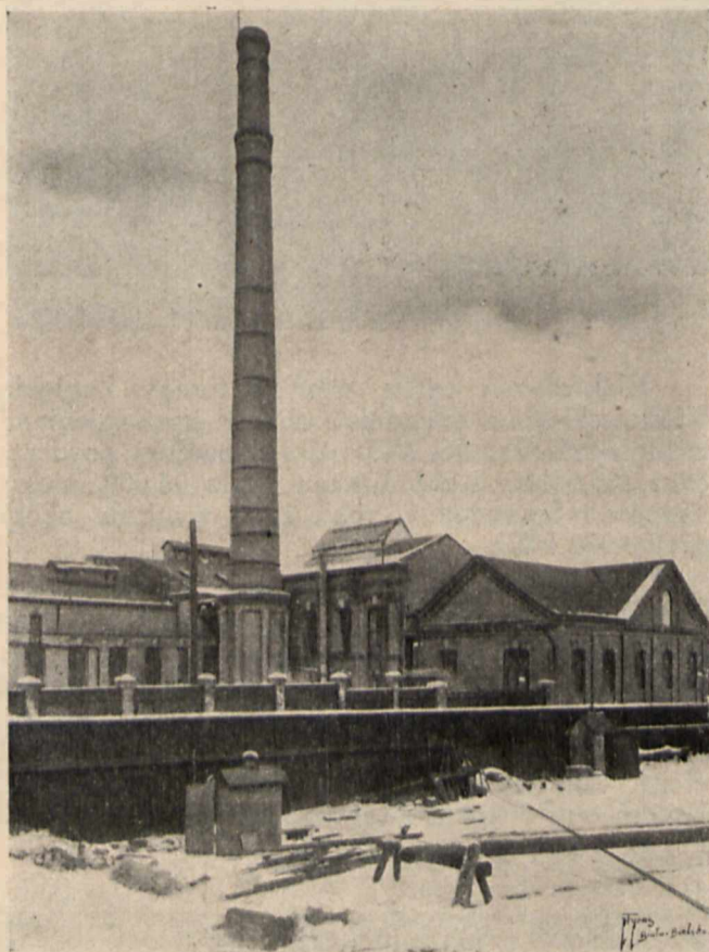
Ogólny widok elektrowni.
